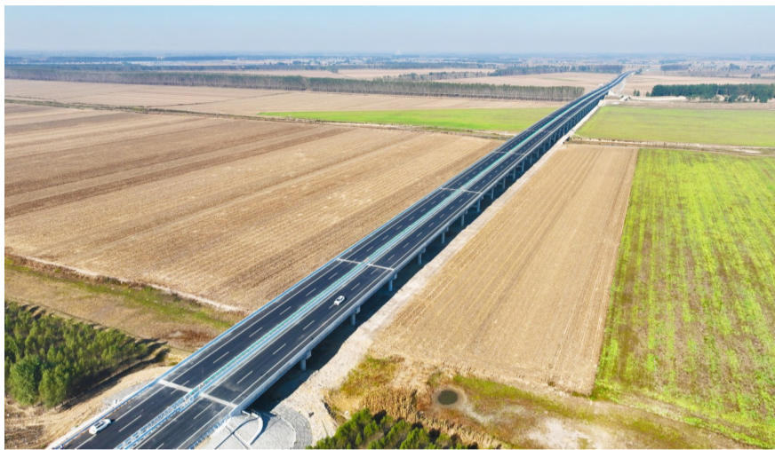
通车后的台黑高速公路绕阳河特大桥
