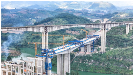
徐家湾大桥引桥T梁架设
