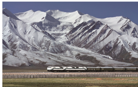
青(海)至(西)藏铁路
