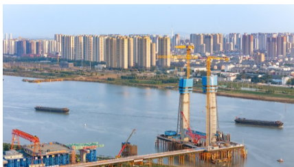
蚌埠延安路淮河大桥首节钢梁顶推完成
