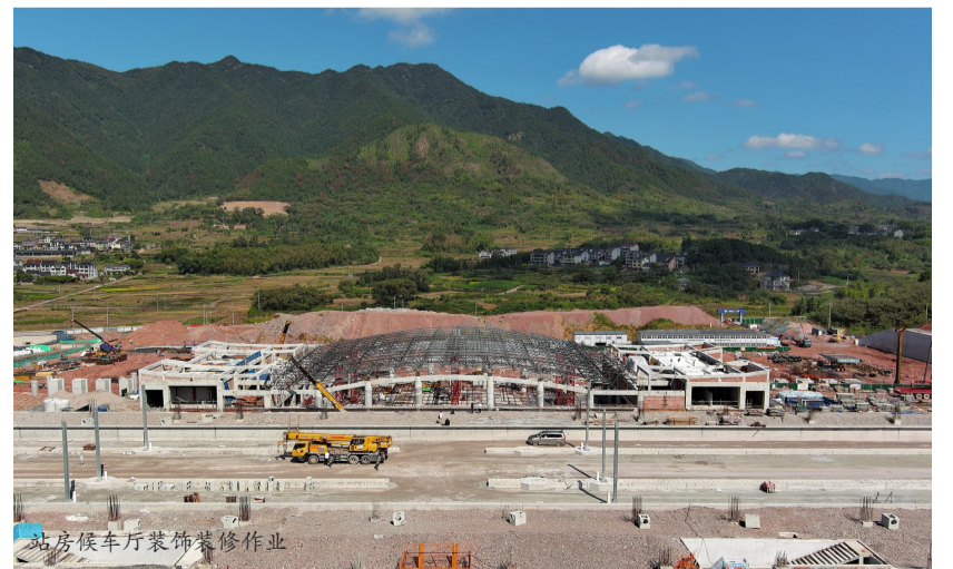
网架整体顶升已完成
