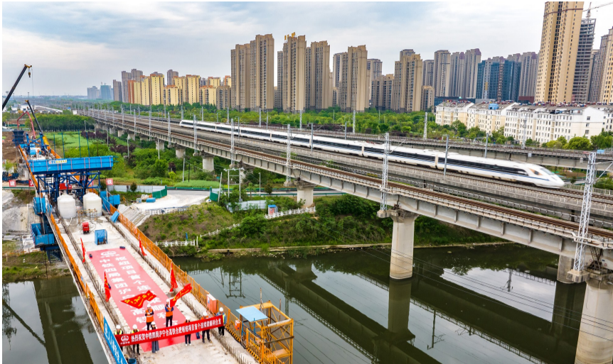
沪宁合高铁引入合肥枢纽跨店埠河连续梁右线合龙
