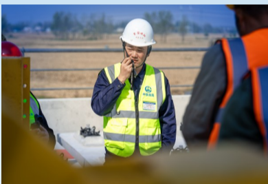
铺轨现场,工作人员正在指挥作业
