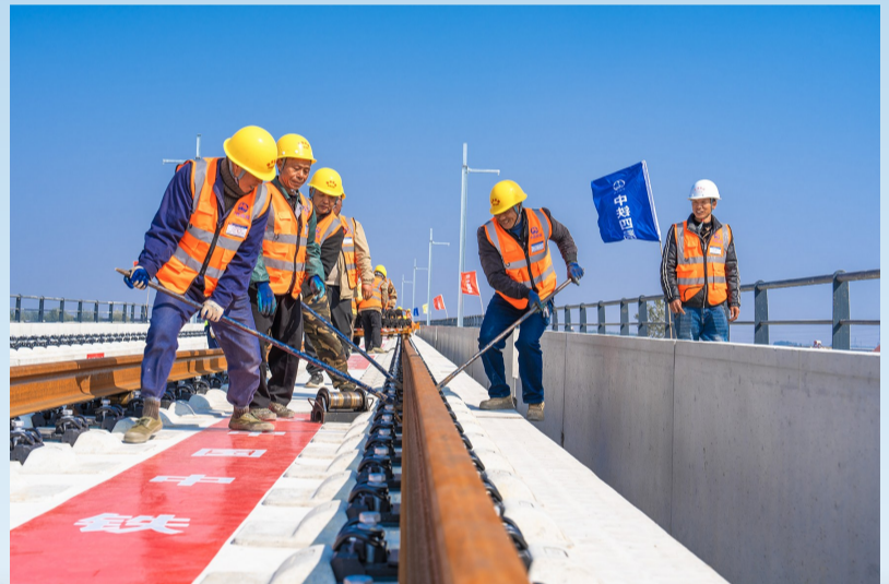
作业人员使用撬棍配合取出滚筒
