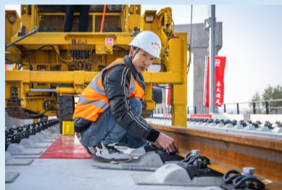
工作人员检查现场扣件安装情况
