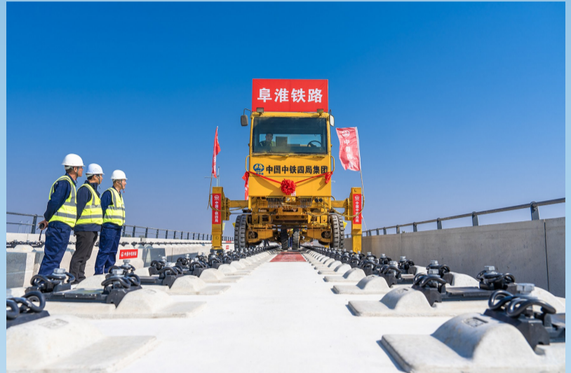
阜淮高铁500米长钢轨铺设作业中
