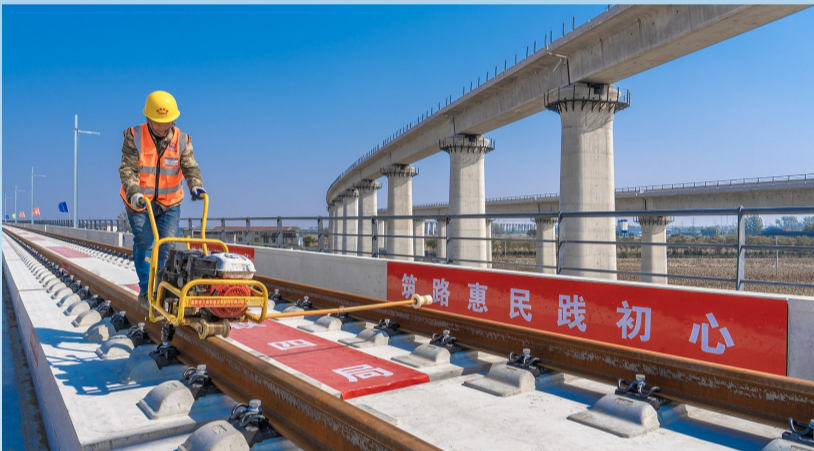
作业人员操作机械旋紧螺栓扣件
