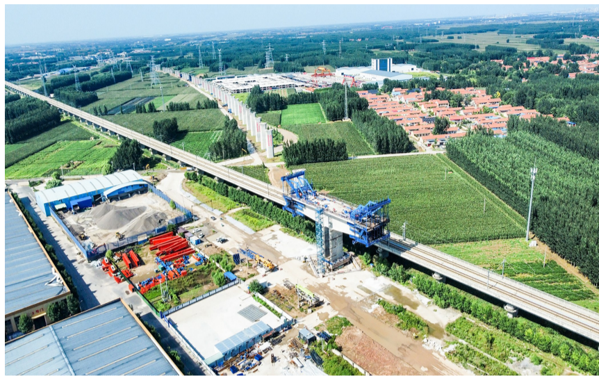
潍宿高铁跨济青高铁转体梁施工
