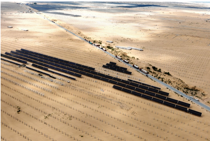
中铁四局承建的内蒙古乌兰察布光伏项目
