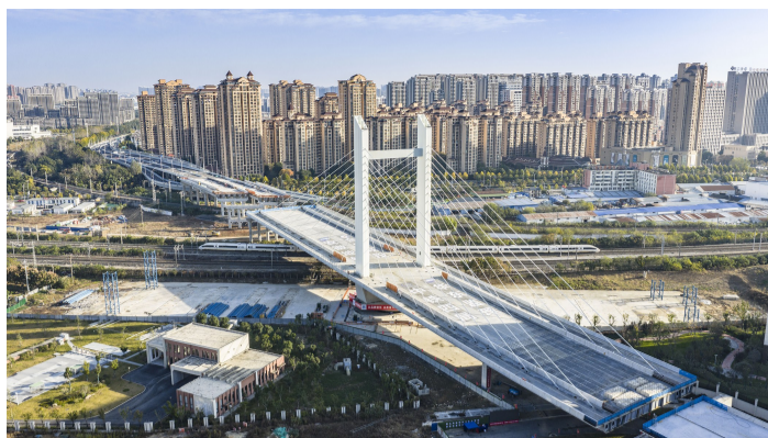
合肥市淮南路独塔双肢双索面斜拉钢箱梁桥顺利完成转体
