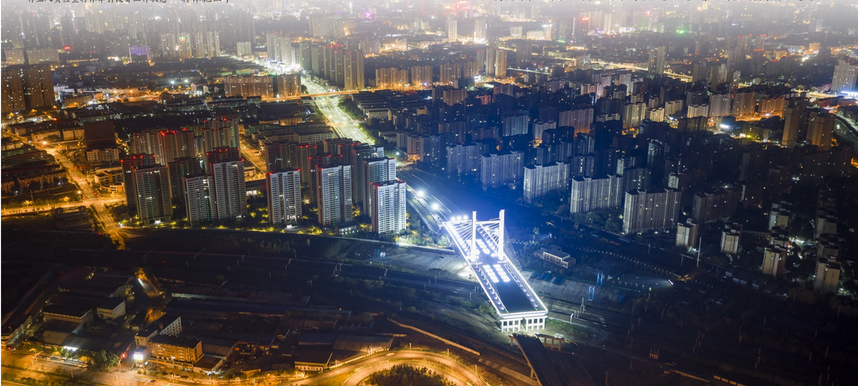
经过120分钟的连续精准作业,转体施工全部完成
