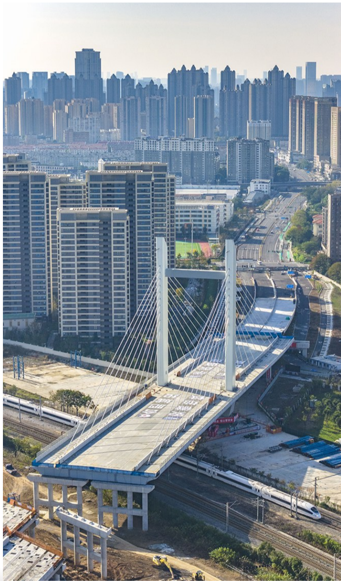
高铁列车从转体后的合肥市淮南路独塔双肢双索面斜拉钢箱梁桥下通过
