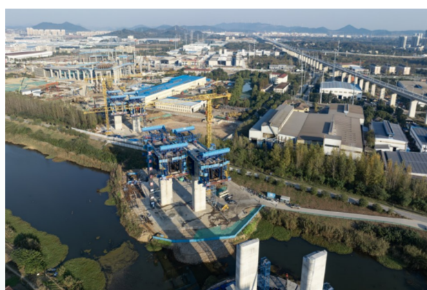
连续梁施工作业
