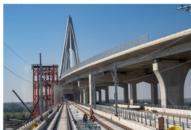
铁路施工现场
