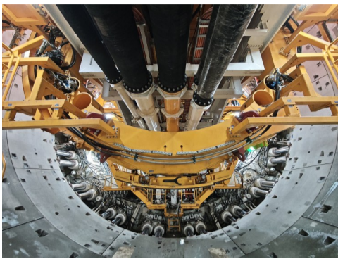
杭州萧山机场西隧道施工现场
