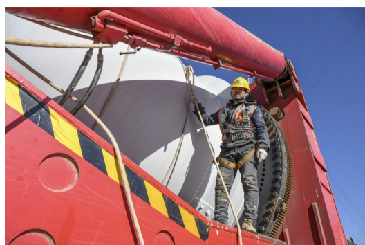
作业人员正在进行相关准备工作
