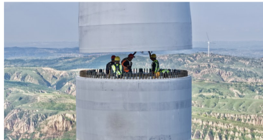
作业人员正在进行钢混连接段拼接施工
