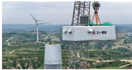
机舱吊装施工
