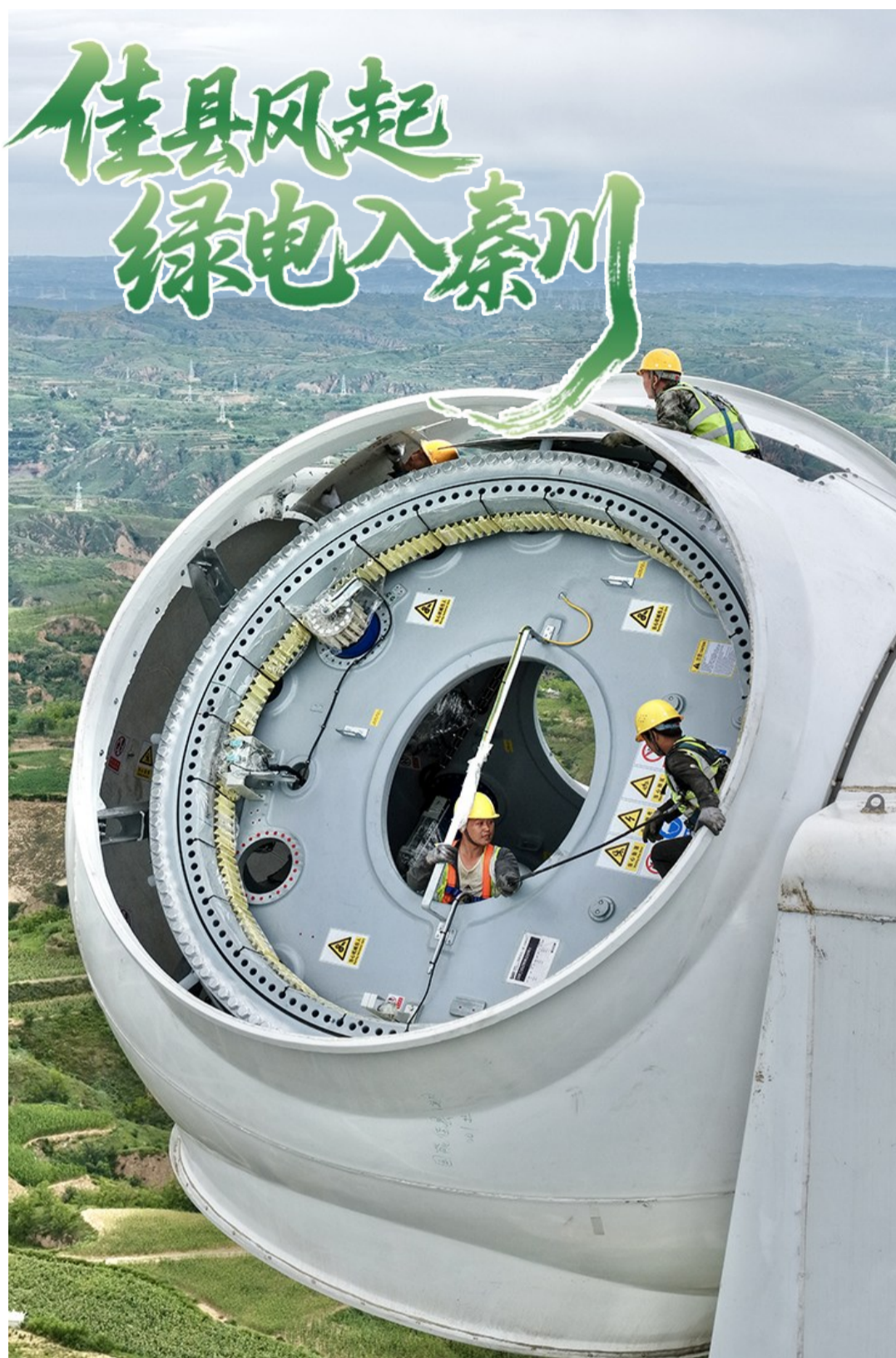
作业人员对风机叶片安装口进行安全质量复核
