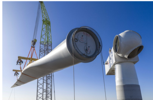
风机叶片吊装施工
