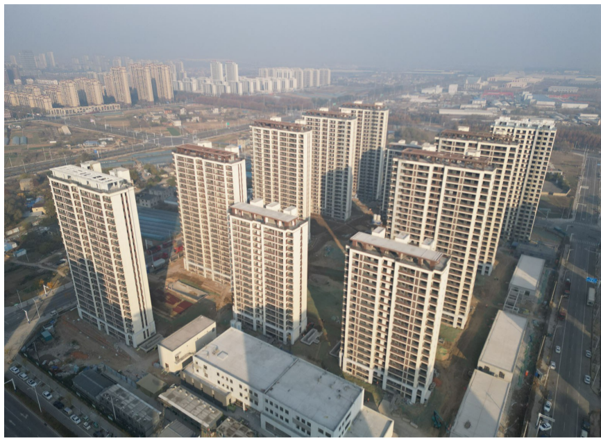
凤凰城安置房一期项目
