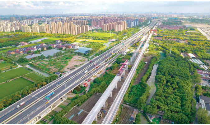
沪宁合高铁沪宁段2标架梁施工现场
