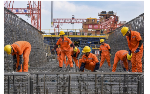
工人正在绑扎钢筋
