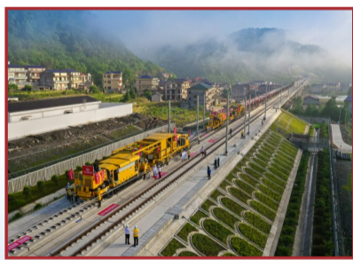
国内首套WPZ-500型无砟轨道智能铺轨机组 吴怀球摄
