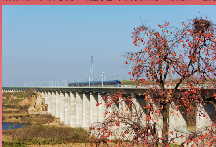
12月26日，中铁四局参建的西(安)延(安)高速铁路开通运营。李向东摄
