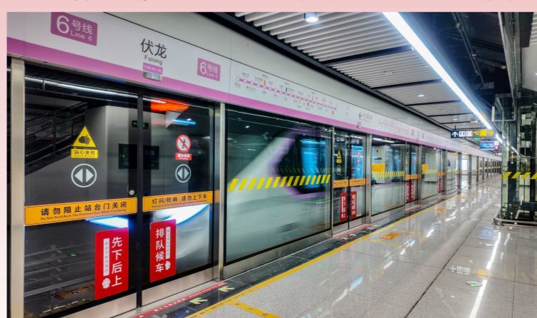
12月26日，中铁四局参建的合肥地铁6号线一期工程正式开通运营。刘志旭摄
