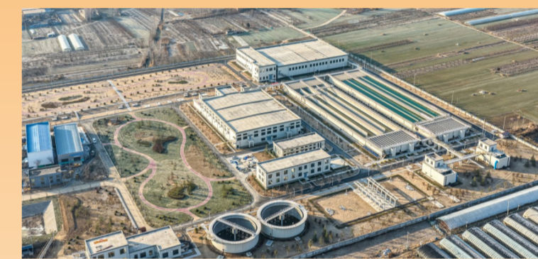
12月28日，中铁四局承建的安徽省砀山县城乡供水一体化工程正式通水。刘玉才摄
