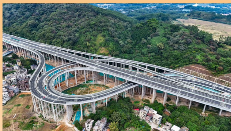
12月31日，中铁四局参建的广东增(城)天(河)高速公路增城至天河段建成通车。王昌盛摄
