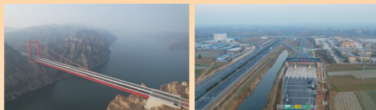
12月30日，中铁四局参建的河南济(源)新(安)高速公路建成通车。王晓一摄
