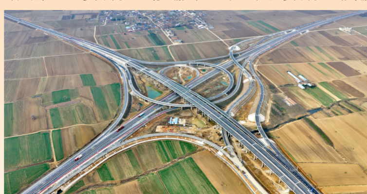
12月30日，中铁四局参建的河南安(阳)罗(山)新(安)高速公路原阳至郑州段建成通车。王仔琦摄
