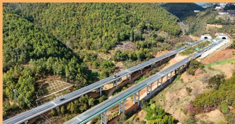
12月31日，中铁四局参建的云南大(理)保(山)高速公路老营至板桥段改线工程建成通车。苏渊博摄
