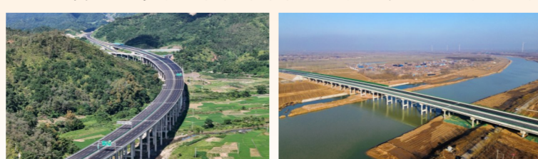
12月28日，中铁四局参建的广东阳(春)信(宜)高速公路建成通车。田应元摄
