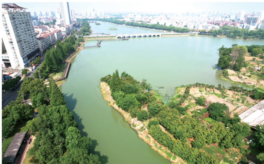
1月5日，中铁四局承建的无为市城乡污水处理一体化二期项目荣获“2024年度共抓长江大保护劳动竞赛先进集体”。该项目覆盖无为市19个乡镇、2个社区，施工内容包括城东污水处理厂提标改造及扩建、环城河治理、城东经开区管网排查修复、一期配套续建管网200公里等。图为无为二期项目环城河治理工程。 程志飞 摄
