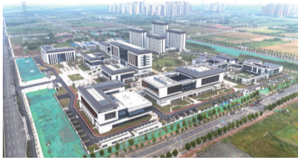
中共合肥市委党校(合肥行政学院)新校区建设工程项目 卢勇龙 摄
