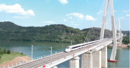
新建汉巴南铁路南充至巴中段HBNZQSG-6标站前工程 郭泽 摄
