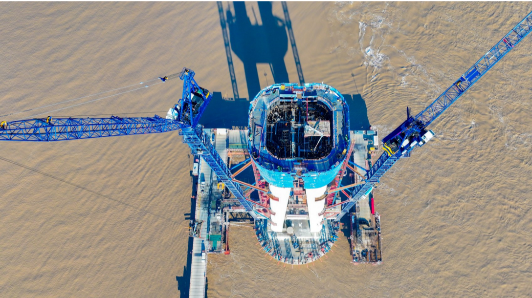
4号主塔中塔柱合拢现场
