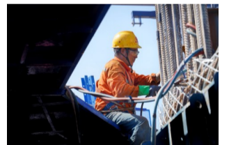
工人正在进行焊接作业
