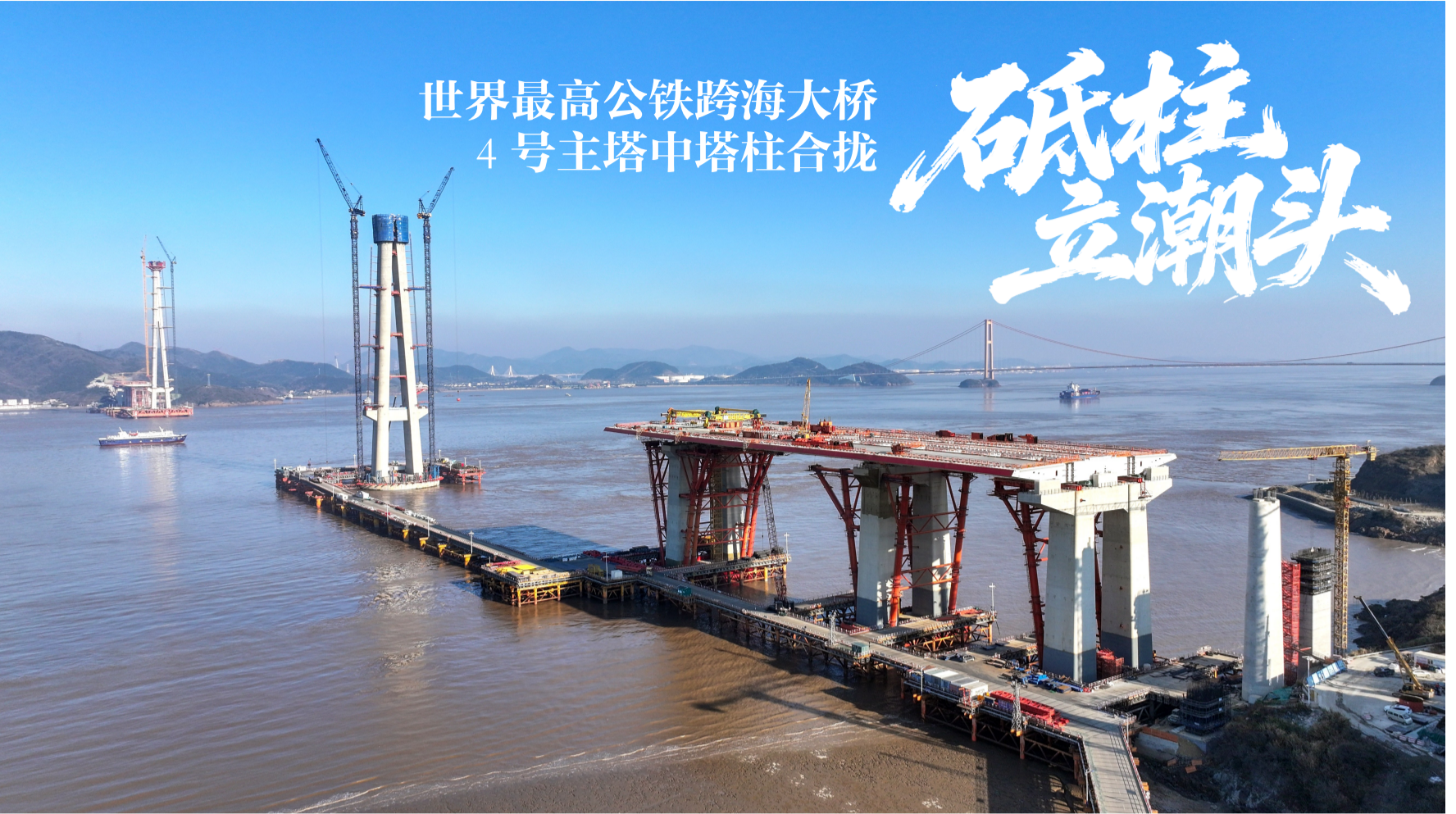
建设中的甬舟铁路西堠门公铁两用大桥
