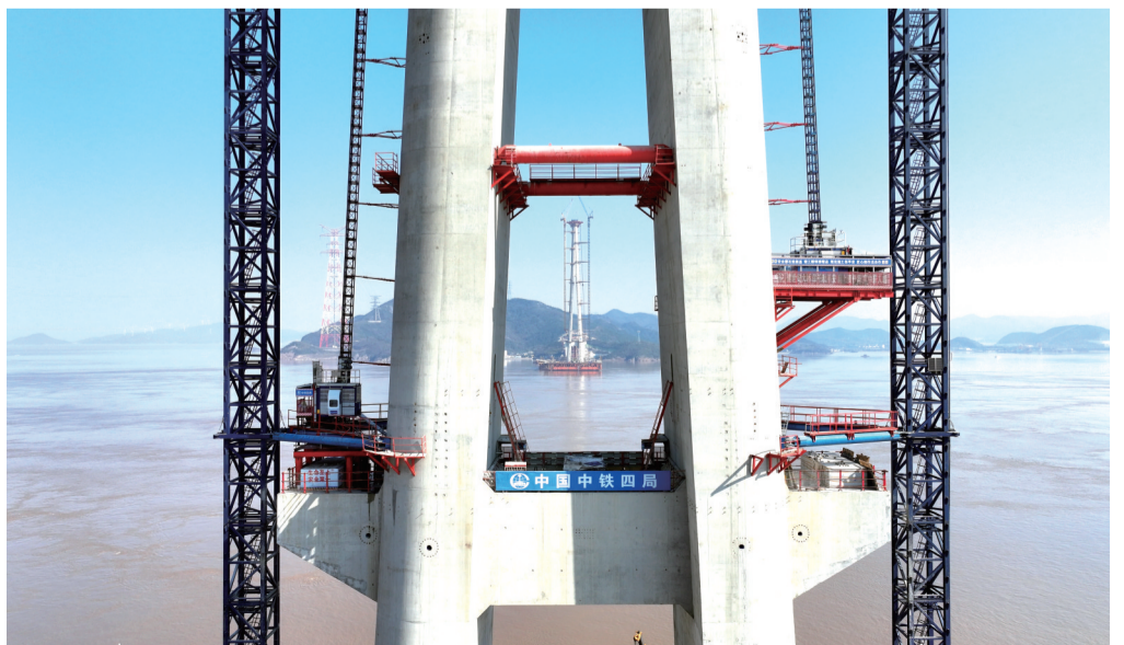
建设中的甬舟铁路西堠门公铁两用大桥4号主塔
