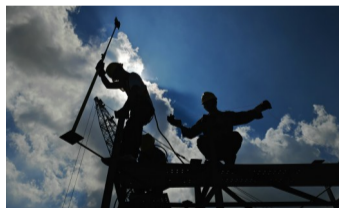
工人正在进行动性骨架定位作业
