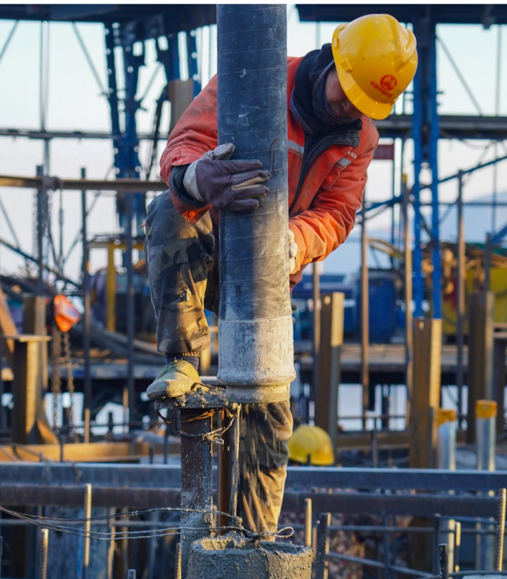
工人使用混凝土泵管浇筑墩身
