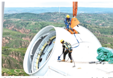
吊装轮毂施工作业
