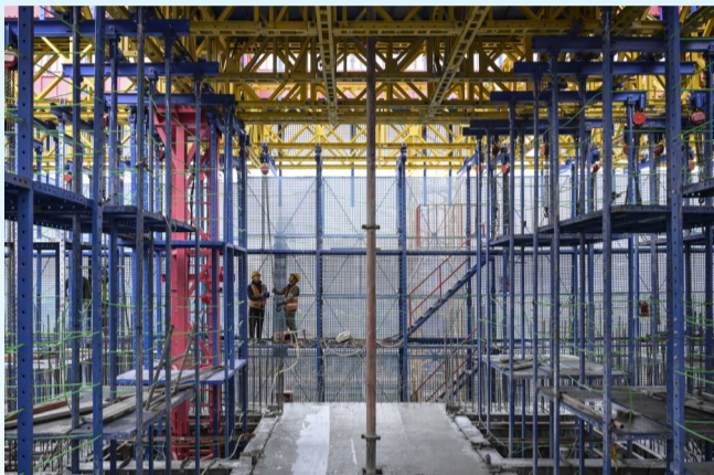
工人在轻型智能造楼机提升前进行铝模板固定作业
