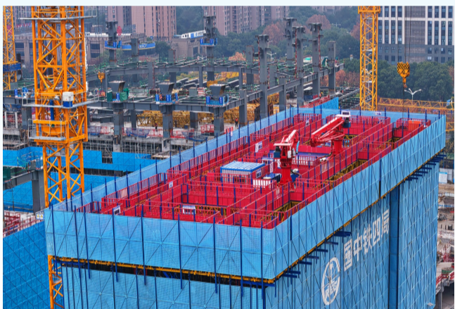
中铁四局合肥轨道交通线网控制中心项目轻型智能造楼机投入使用
