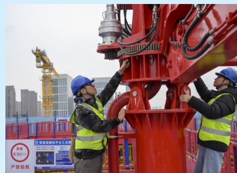
管理人员对轻型智能造楼机液压布料平台进行检查
