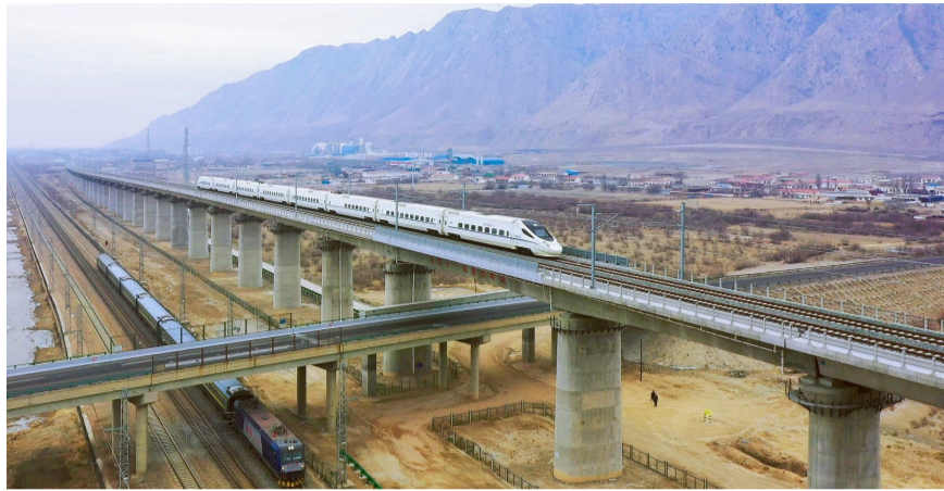
D4667次动车组列车行驶在包银高铁跨215省道特大桥上。
