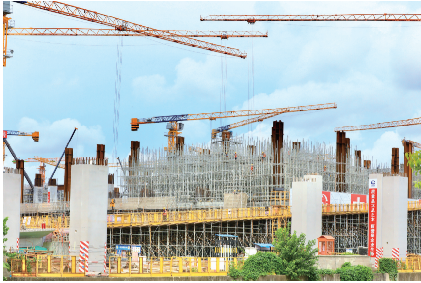
集疏运道路S4匝道桥和站房支架架设
