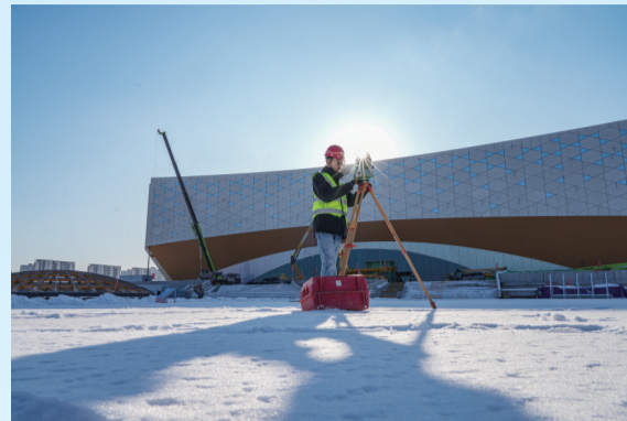
技术人员正在进行放线定位
