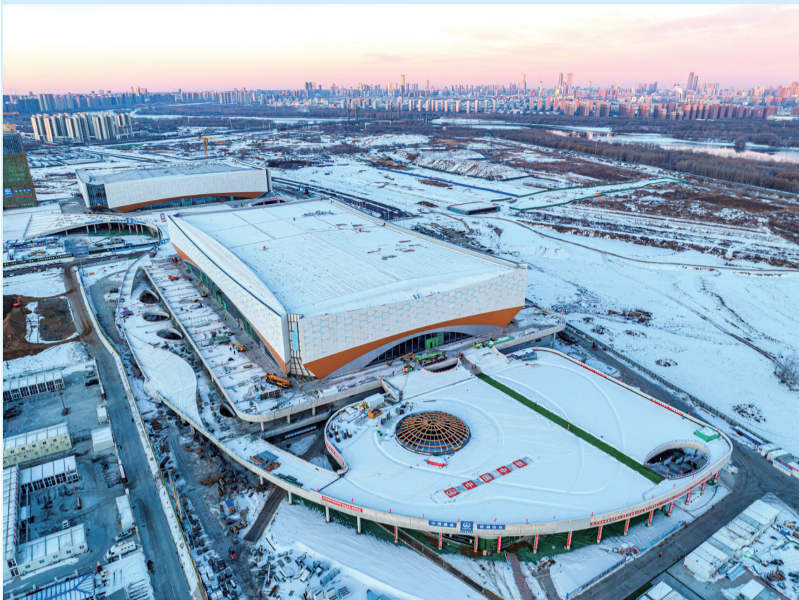
建设中的沈阳王家湾冰上运动中心项目
