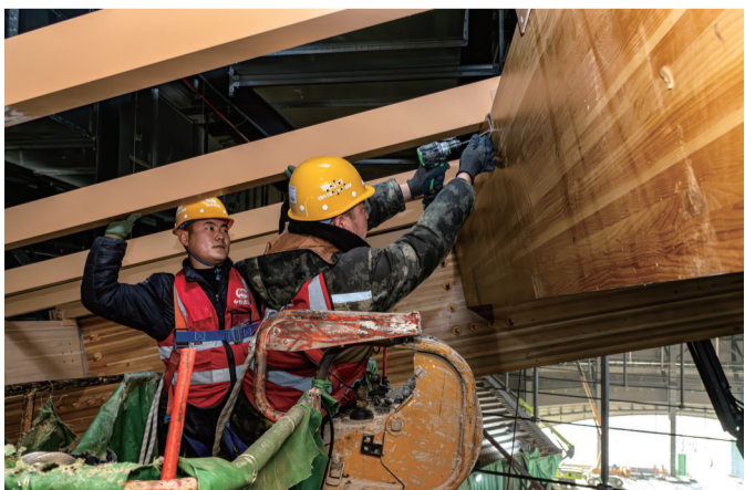
工人正在安装速滑馆铝龙骨
