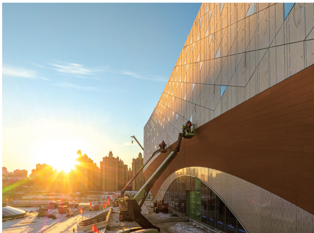
幕墙仿木纹铝板安装现场
