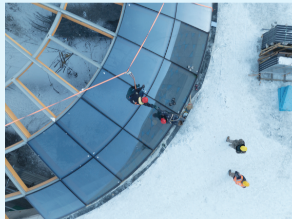
游泳馆穹顶玻璃安装施工
