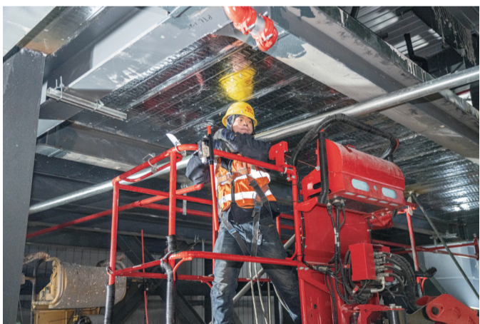
工人正在安装消防水管
