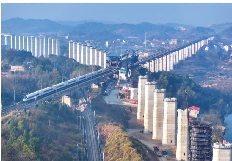
1月14日，中铁四局承建的邵(阳)永(州)铁路1标跨沪昆高速铁路特大桥转体桥梁工程进入上部结构施工阶段。邵永铁路全长96公里，1标管段正线长34.233公里，施工内容包括路基、桥梁等。其中，跨沪昆高速特大桥长4.051公里。
