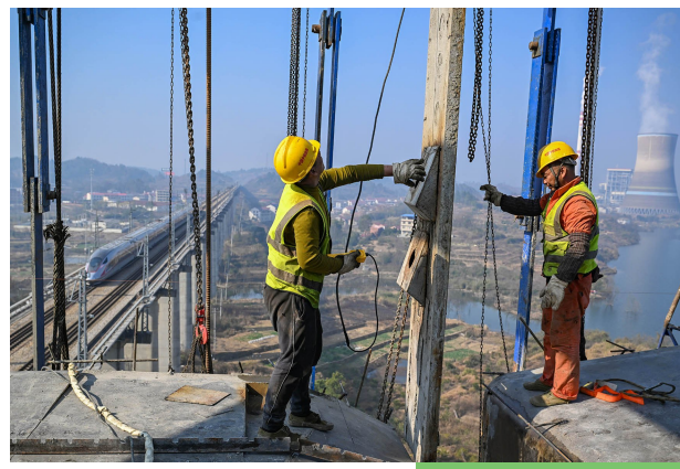
工人正在进行模板安装作业
