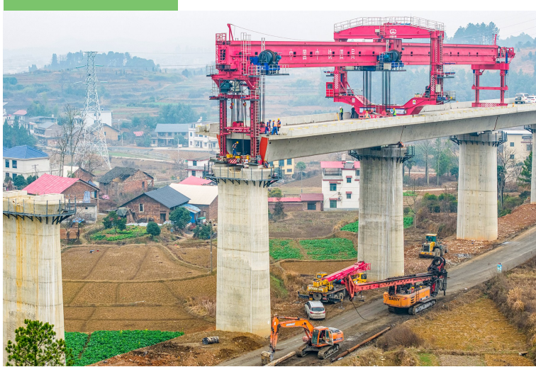
邵永高铁肖吉普特大桥箱梁架设作业
