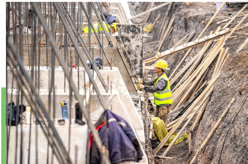
工人正在进行钢筋绑扎作业
