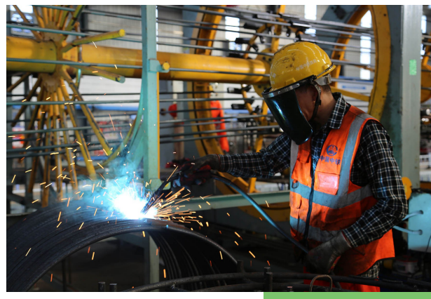
工人正在进行钢筋焊接作业
