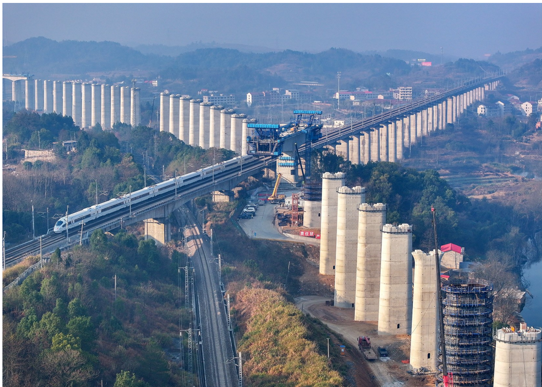
建设中的邵永高铁
