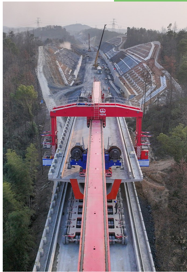
邵永高铁站前1标架梁施工现场
