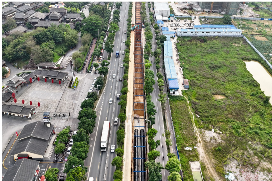
罗文大道管道安装施工
