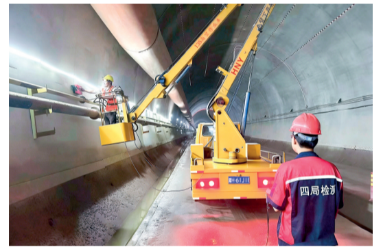
检测人员通过地质雷达检测隧道二衬质量 鲍伟摄
