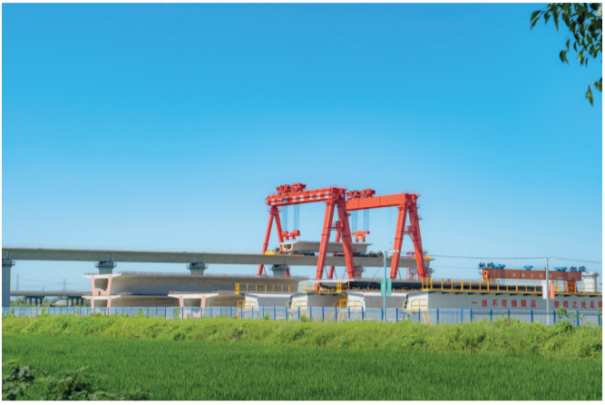
工程技术公司参建的合武高铁湖北段黄花涝府河特大桥 鲍伟摄
