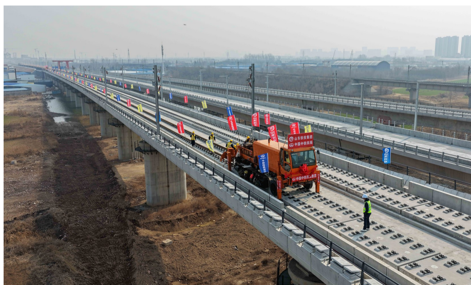
济滨高铁首列长钢轨开铺
