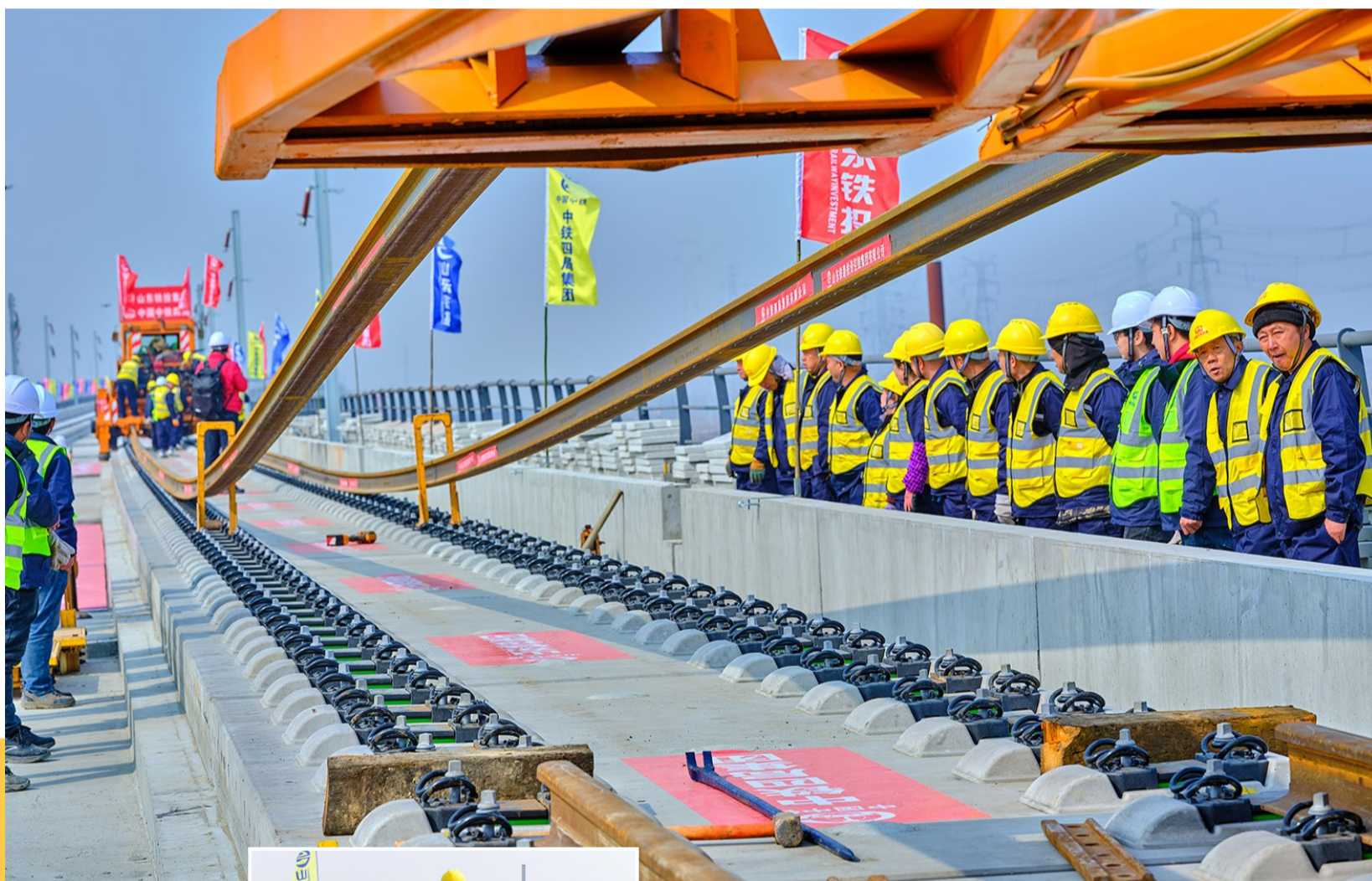
无砟轨道铺轨机组配合牵引车进行长钢轨推送
