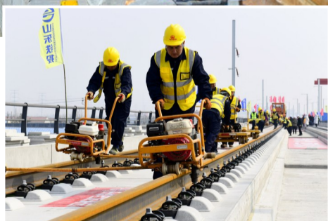
作业人员紧固扣配件
