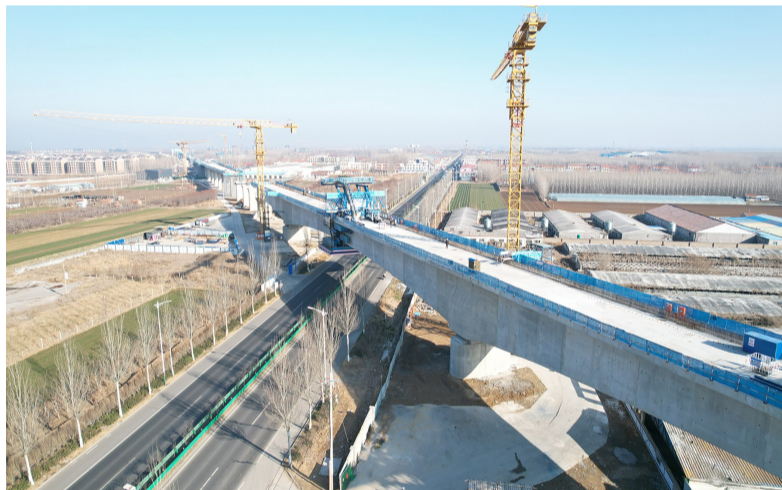
3月13日,中铁四局承建的潍(坊)宿(迁)高速铁路1标潍坊特大桥跨G206国道大跨度双线连续梁合龙。1标管段正线全长28.513公里,施工内容包括路基、桥梁、无砟轨道铺设等,其中跨G206国道连续梁长270.6米。 刘飞 蔡小泉 摄
