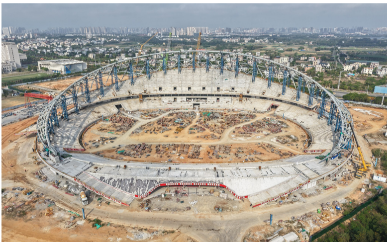
3月23日,中铁四局承建的中国东盟(北海)体育实训基地项目体育场钢屋盖结构合龙。该项目总建筑面积12.1万平方米,建设内容包括主体育场、体育综合馆、跳水游泳馆、常训馆等。此次合龙的体育场钢屋盖结构总用钢量约7400吨,设计为国际领先的“双层索桁架+PTFE膜结构”。 张晓慧 张志华 摄
