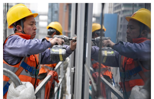
工人正在进行玻璃幕墙安装施工
