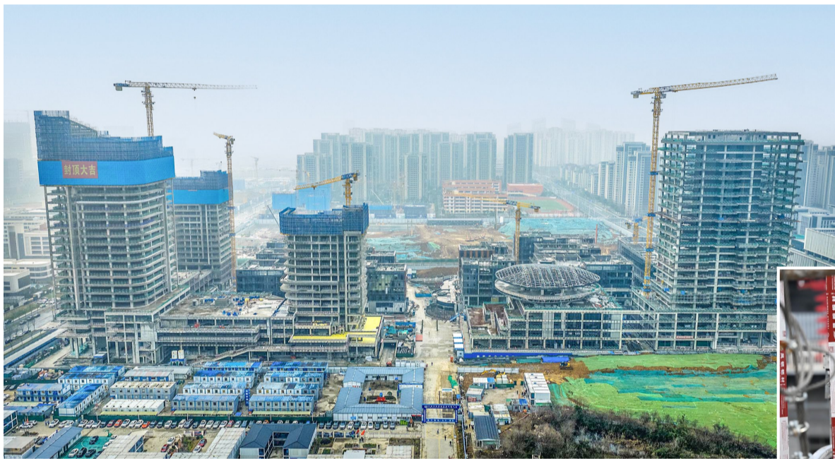
合肥芯智汇科技产业园(二期)项目建设现场
