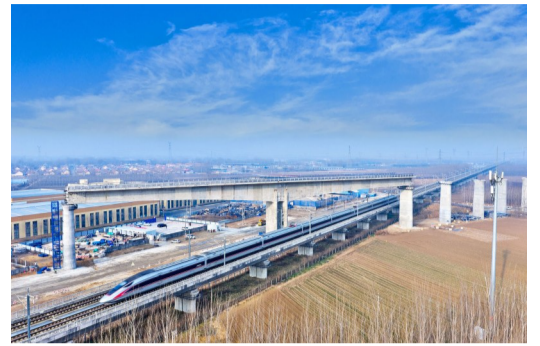
杨晨 杨安治 淮宿高速铁路跨青高速铁路转体梁转体完成 史家民 摄
