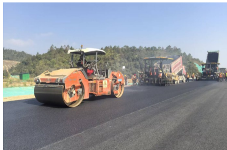
工人正在进行沥青摊铺作业
