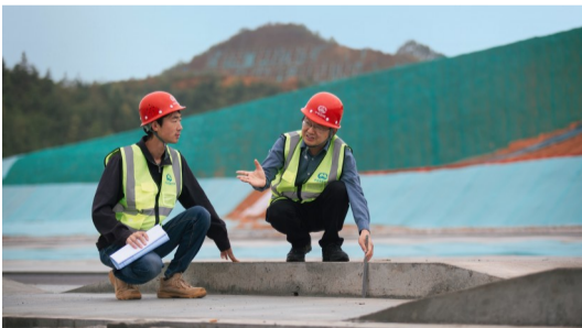
全国劳模、中铁四局试验检测与测量管控中心高级专家张杰胜(右)正在讲解特种路面技术要点
