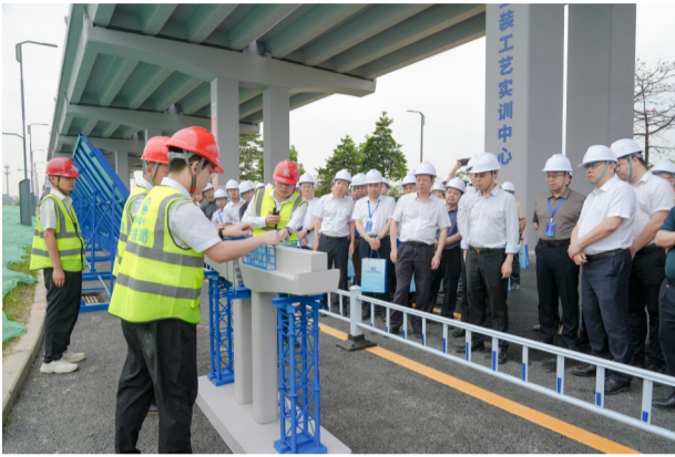
参会人员实地观摩装配式桥梁施工工艺
