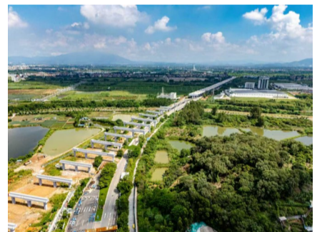
新江路跨线桥架梁
