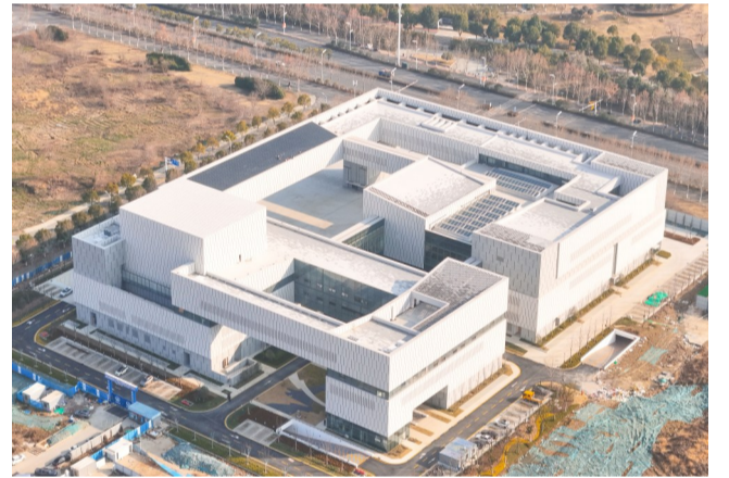
主体完工后的安徽省“两馆”项目鸟瞰
