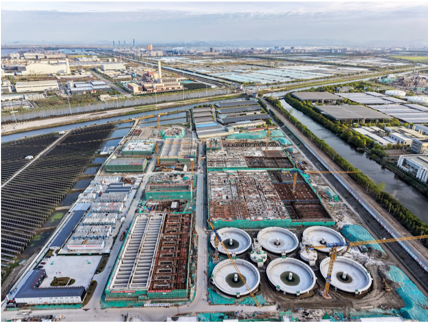
杭州临江高新污水处理厂项目航拍
