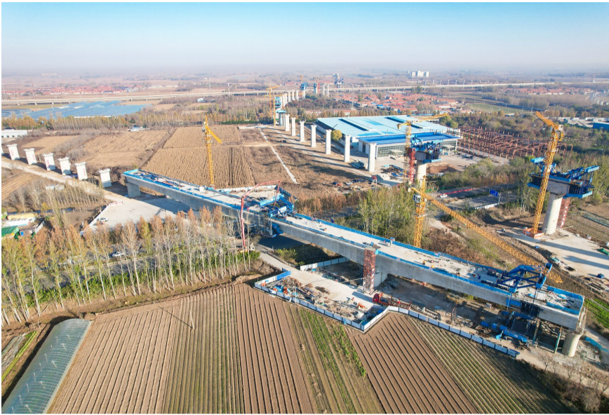
淮宿高铁1标滩坊特大桥跨G206国道连续梁合龙
