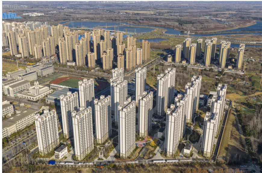
合肥义城安置点D地块项目航拍
