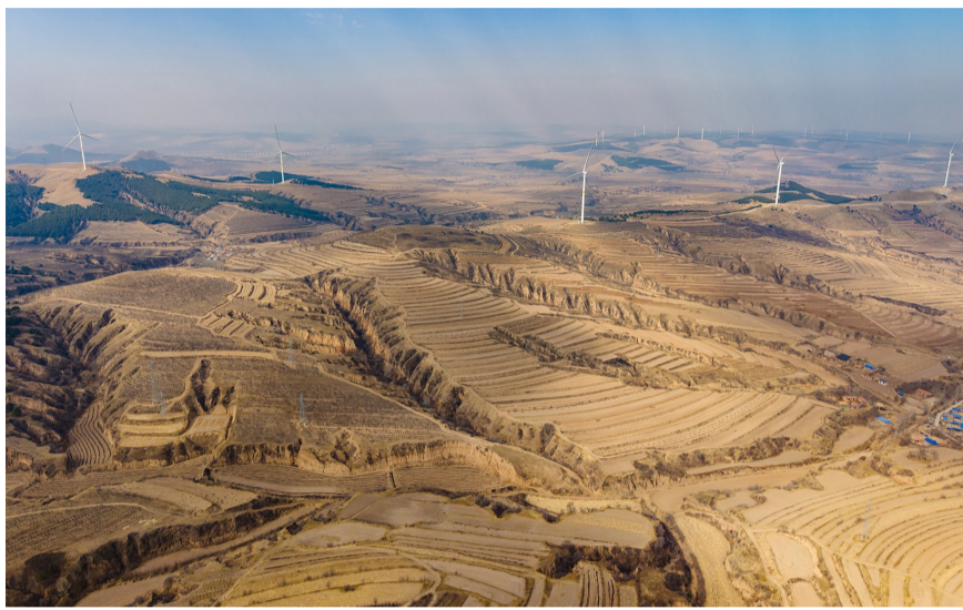
三道窝铺村坡耕地田块整治施工航拍
