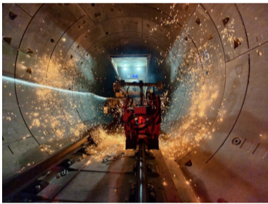
新能源焊机在隧道内进行钢轨焊接
