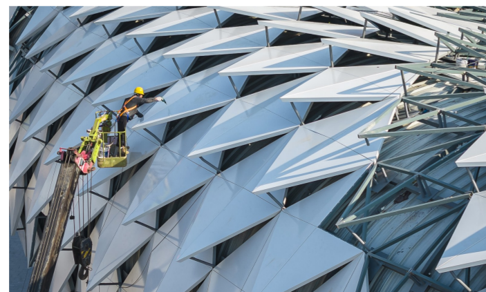
工人正在进行铝板安装作业
