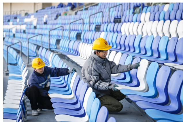
工人正在安装座椅
