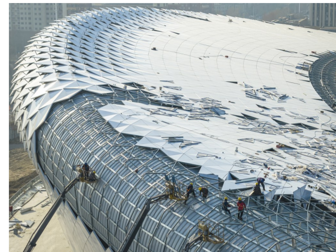
体育场屋面铝板安装现场
