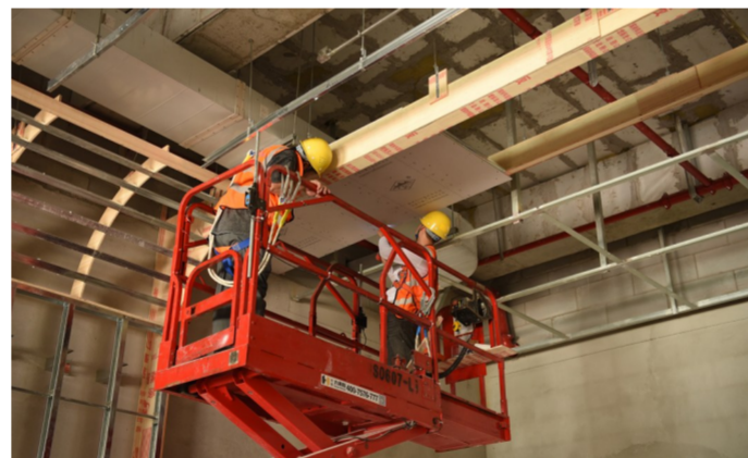
工人正在进行内部装修作业
