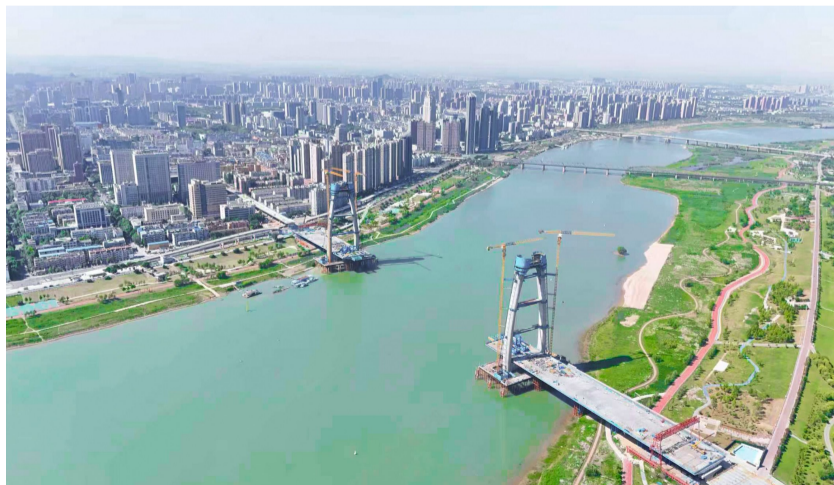
5月6日，中铁四局承建的蚌埠市延安路淮河大桥主塔封顶。该工程线路全长2733米，其中主线桥长2270米，跨河段为双塔双索面斜拉桥，长度839.8米，主跨420米，为淮河流域主跨最大桥梁。此次封顶的主塔高141米。
