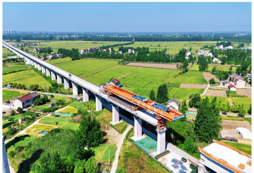
5月10日,中铁四局承建的宁(南京)淮(安)城际铁路6标准安方向箱梁架设任务全部完成。
