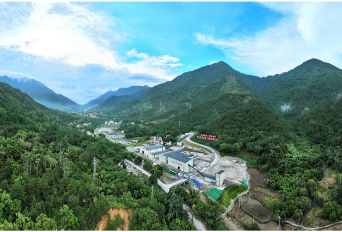
贵子支洞工区航拍
