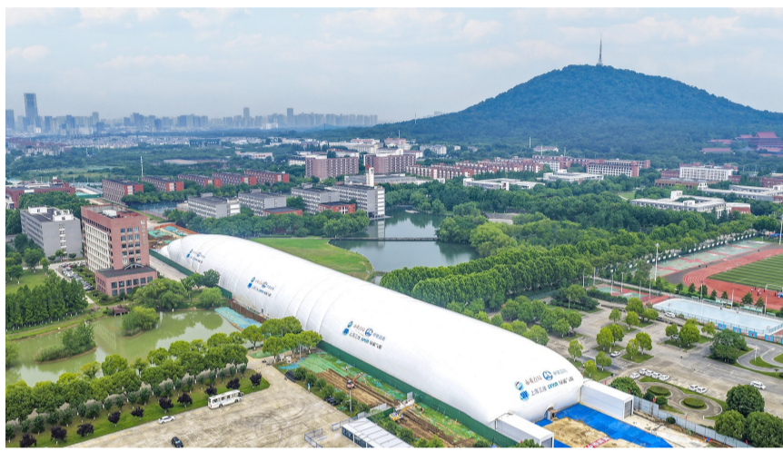
合肥市南二环西延(西二环至永和路)2标项目采用大跨度气膜全封闭基坑施工技术 刘志旭 摄
