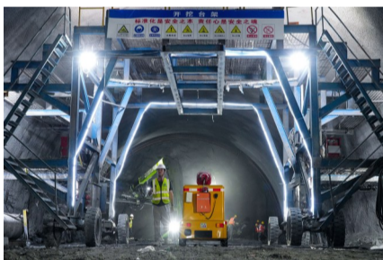
技术员与隧道AI智能安全巡查机器人共同巡检 沈嘉鹏摄
