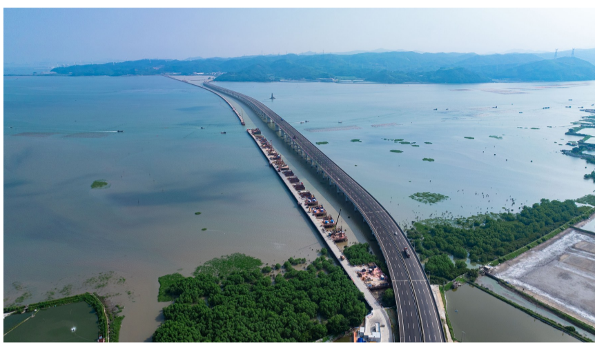
漳江湾跨海特大桥海上主栈桥
