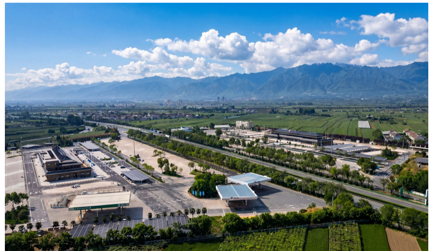
西北地区首个风光储多能互补供一体化零碳智能服务区——连霍高速公路眉县服务区 杨健摄
