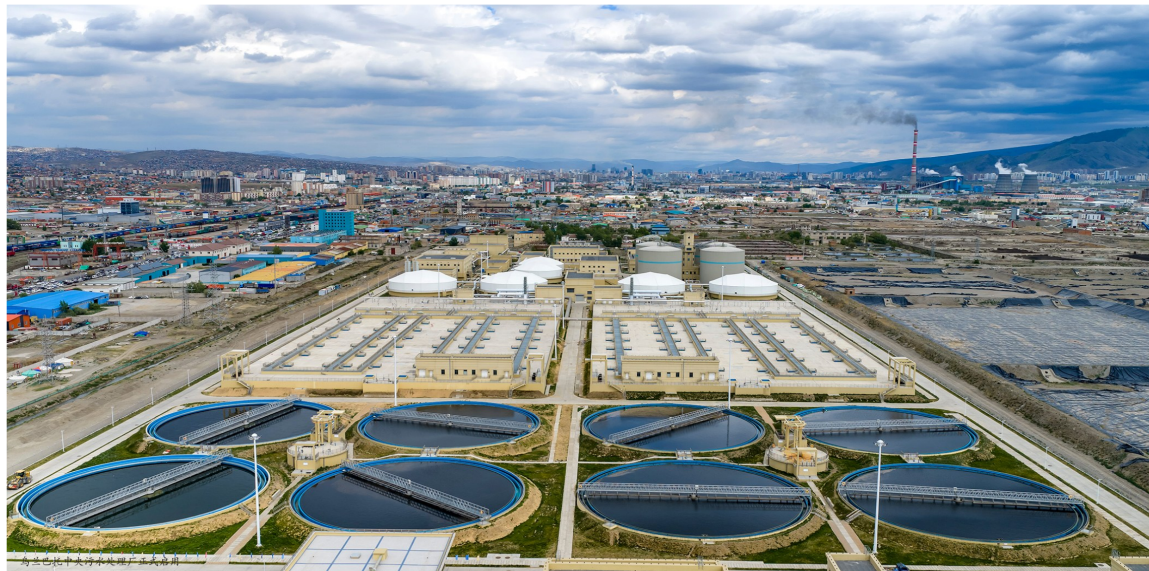
乌兰巴托中央污水处理厂正式启用
