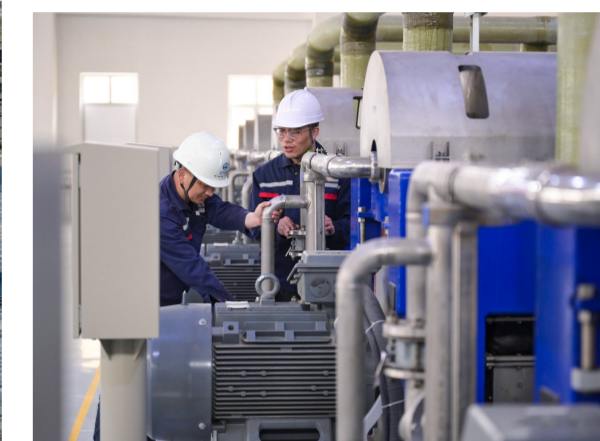
技术人员正在调试设备
