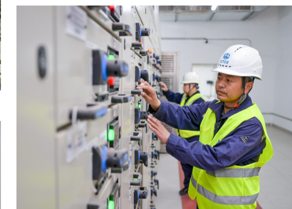
技术人员正在调试设备
