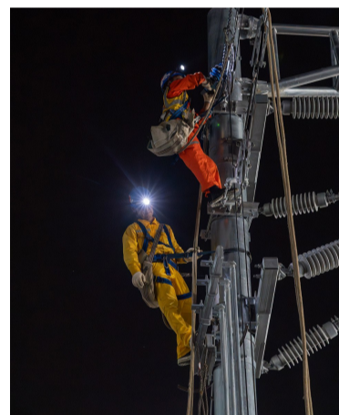
施工人员同步开展接触网作业
