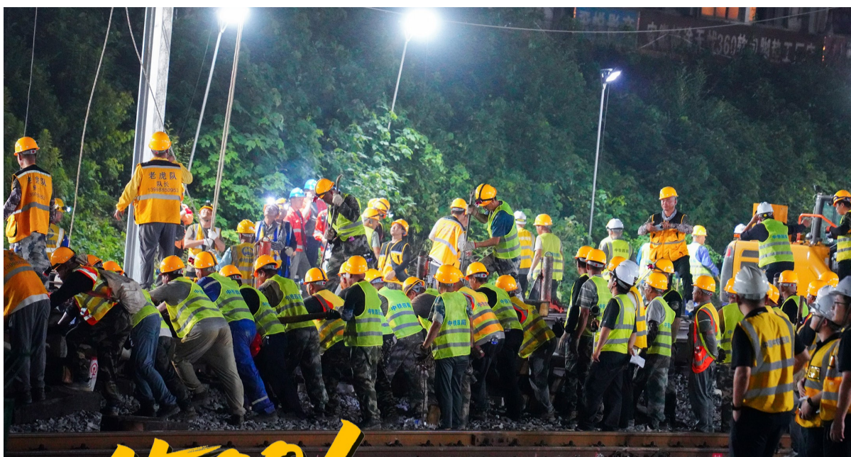
施工人员协同完成线路改造作业
