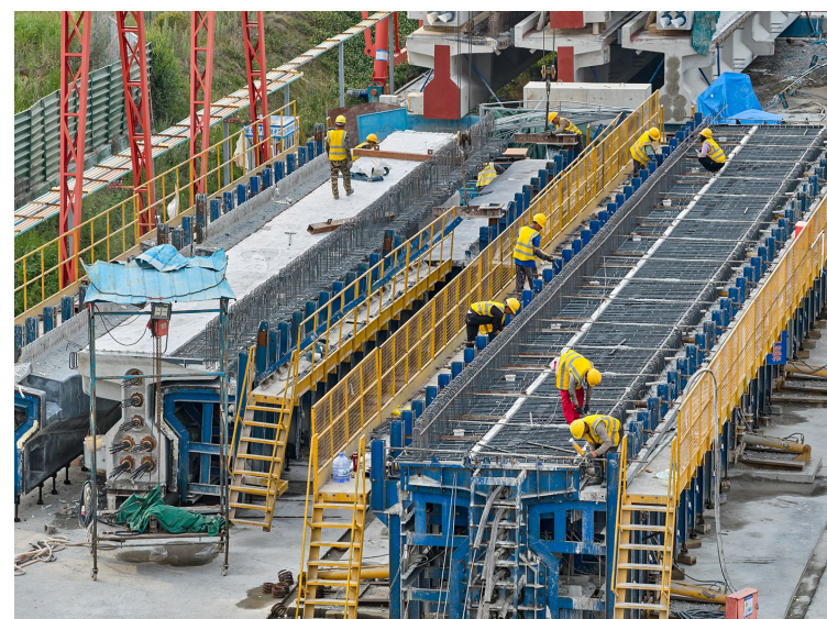
工人正在绑扎T梁钢筋
