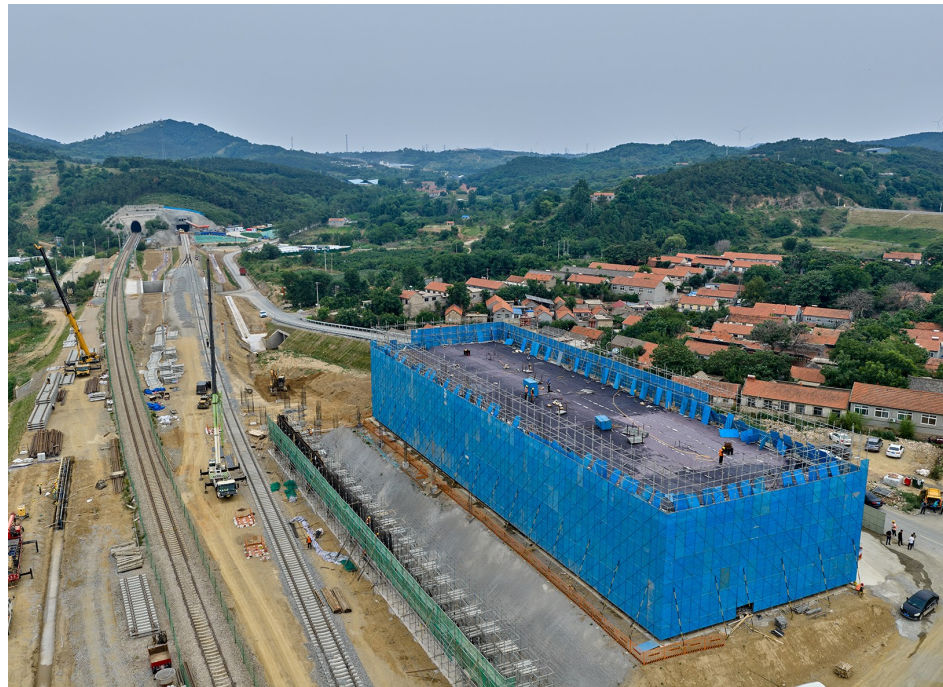
古现南站主体结构顺利封顶
