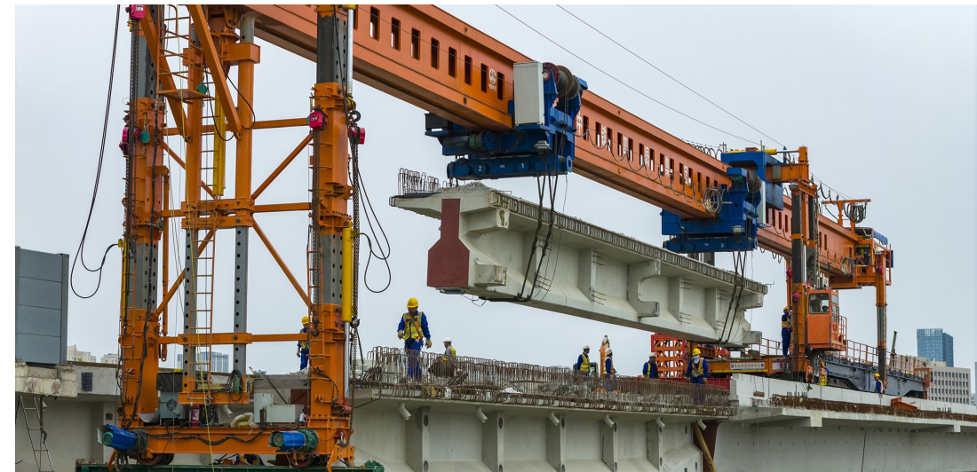
运梁作业现场
