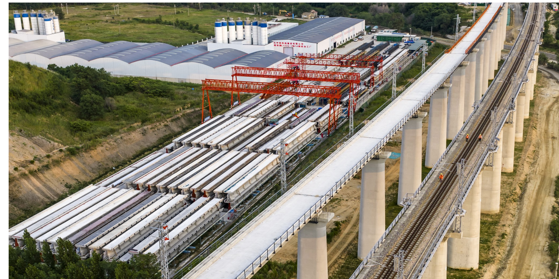
烟台西制梁场内，码放整齐的预制箱梁
