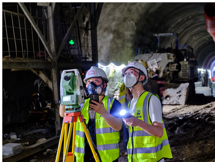
技术人员在隧道内进行测量
