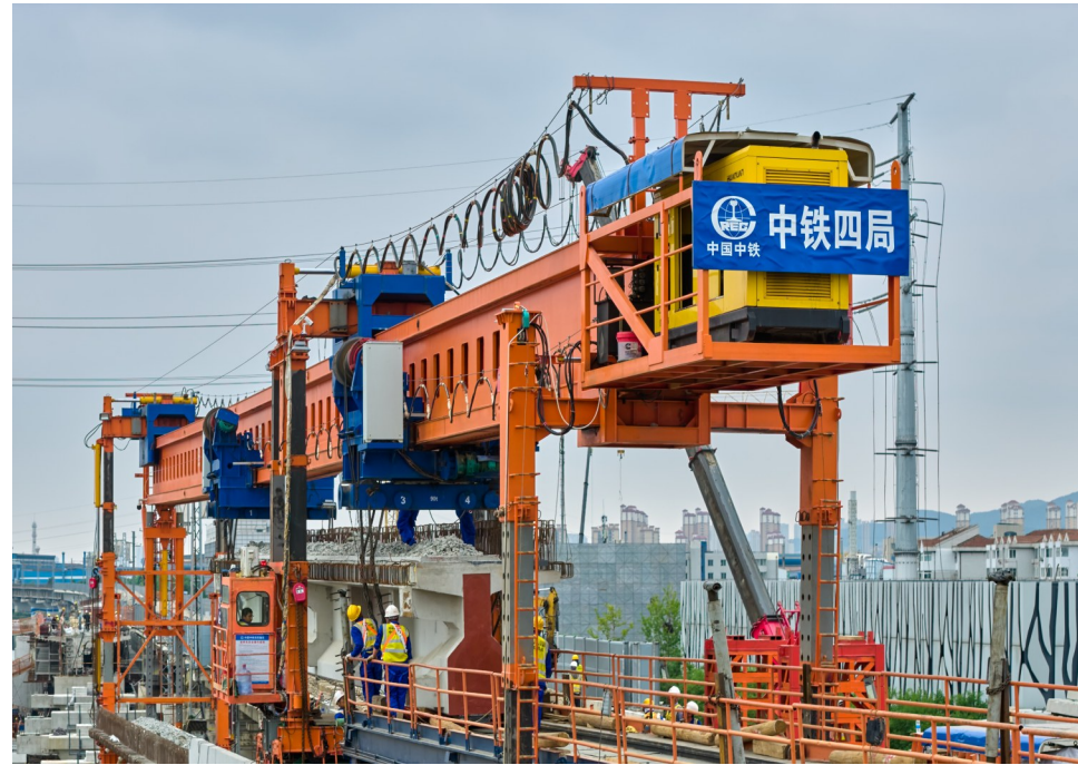
架梁作业现场
