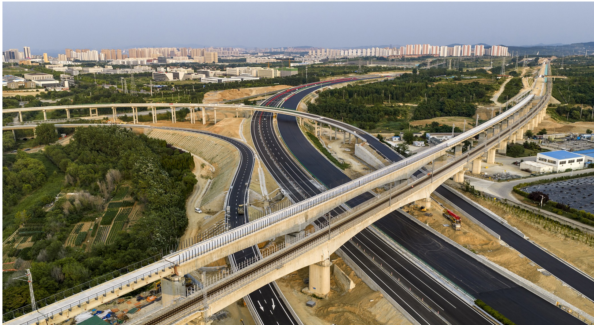
建设中的跨荣乌高速公路特大桥
