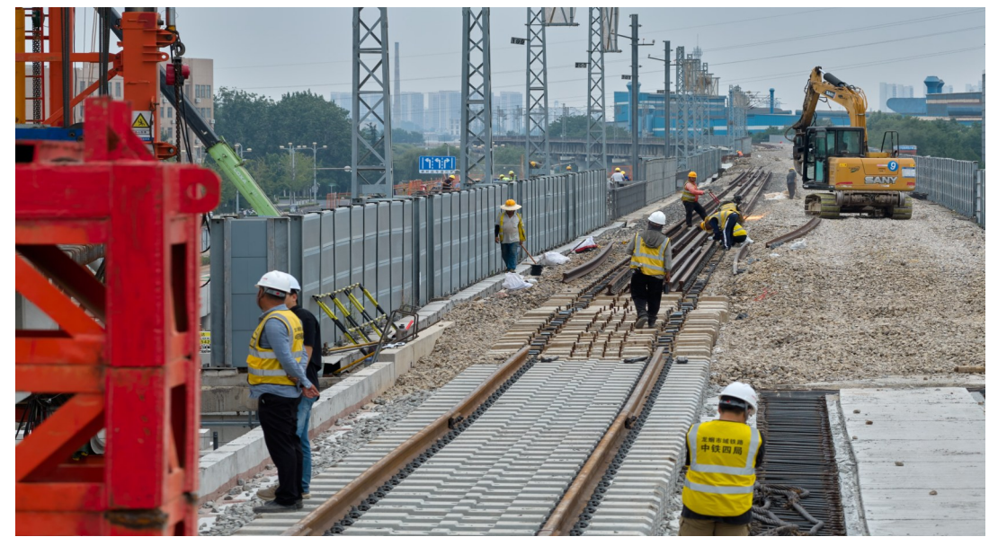
运架梁通道铺设现场
