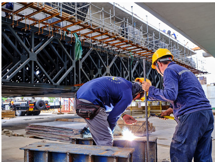
工人正在进行焊接作业
